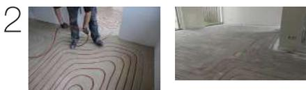
**СИСТЕМЫ С ГОРЯЧЕЙ ВОДОЙ - СУХИЕ СИСТЕМЫ**
