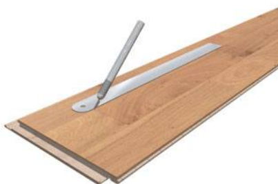
Надрежьте лаковый слой в местах соединения плашки. Используйте линейку.
