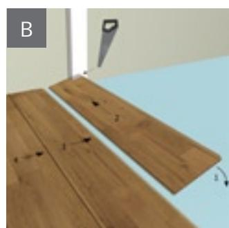
**C.** Отпилите 2/3 профиля в местах, где доски нельзя соединить под углом. После этого доску можно будет установить на место. Нанесите на гребень замка клей, чтобы соединение не ослабло.
