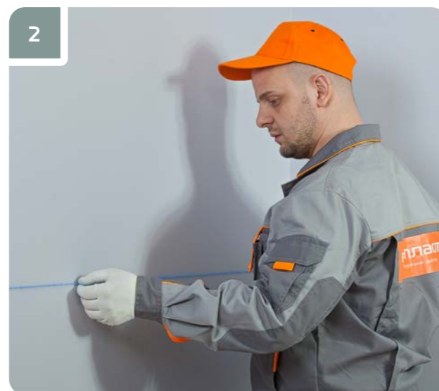
2 С помощью отбивочного шнура соединить отметки по периметру помещения.
