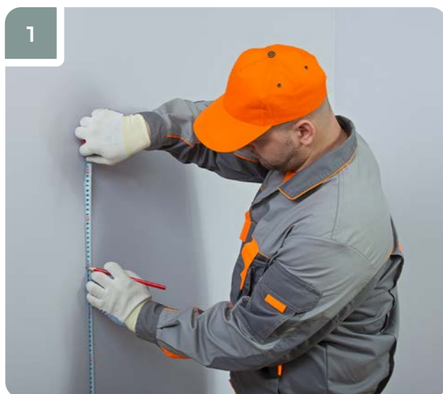
1 Сделать отметки от пола до верхнего края изделия.
