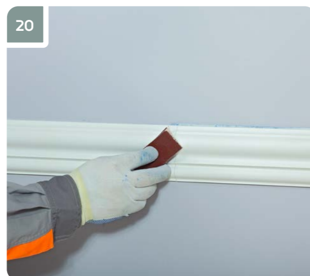
20 Обработать стыки мелкозернистой наждачной бумагой спустя 4 часа, если при монтаже изделий к стене использовался клей «Европласт Универсальный». Обработать стыки спустя 12 часов, если при монтаже изделий использовался клей «Европласт Монтажный».
