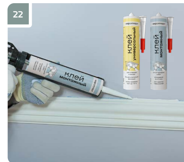
22 Заполнить клеем места примыкания изделия к стене на тех участках, где клей не выступил.
