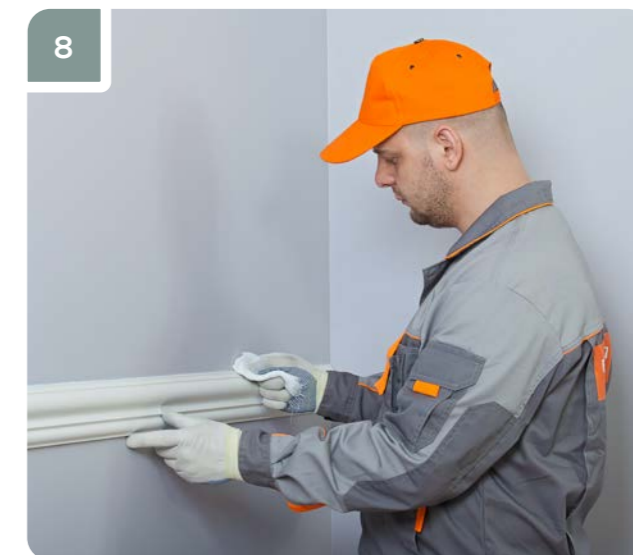
8 При необходимости места примыкания изделия к стене протереть ветошью, смоченной водой — при использовании клея «Европласт Монтажный»; ацетоном — при использовании клея «Европласт Универсальный».
