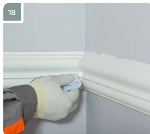
18 Протереть стык ветошью, смоченной ацетоном.
