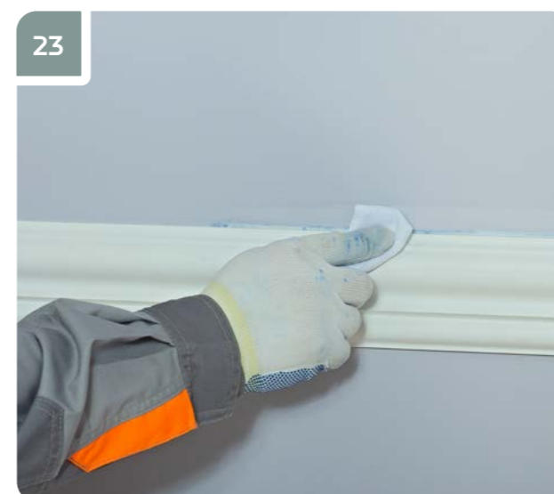
23 Удалить излишки клея ветошью, смоченной водой — при использовании клея «Европласт Монтажный»; ацетоном — при использовании клея «Европласт Универсальный».
