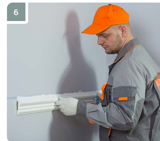
6 Приложить изделие к месту установки согласно разметке на стене. Прижать изделие по всей длине, чтобы клей выступил из-под всей плоскости примыкания.
