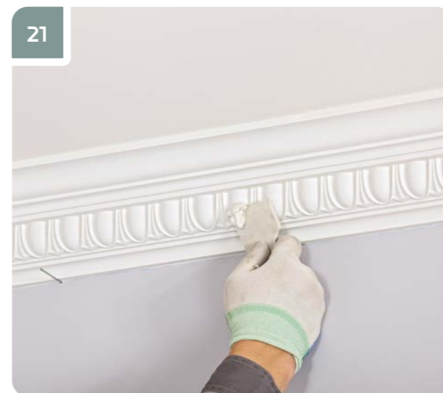
21 Финишной шпаклевкой для внутренних работ зашпаклевать обработанные стыки и места заглубления саморезов. После высыхания шпаклевки при необходимости повторить «Шаг 20».
