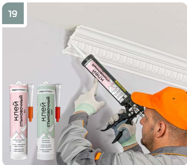
19 Продолжить монтаж следующего изделия.
