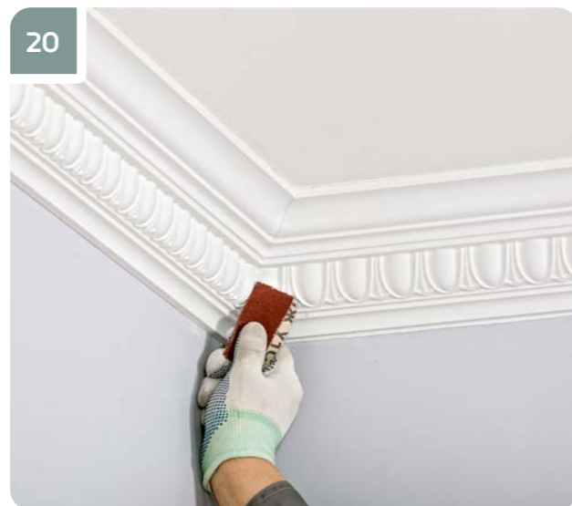
20 Обработать стыки мелкозернистой наждачной бумагой спустя 4 часа, если при монтаже изделий к стене и потолку использовался клей «Европласт Универсальный». Обработать стыки спустя 12 часов, если при монтаже изделий использовался клей «Европласт Монтажный».
